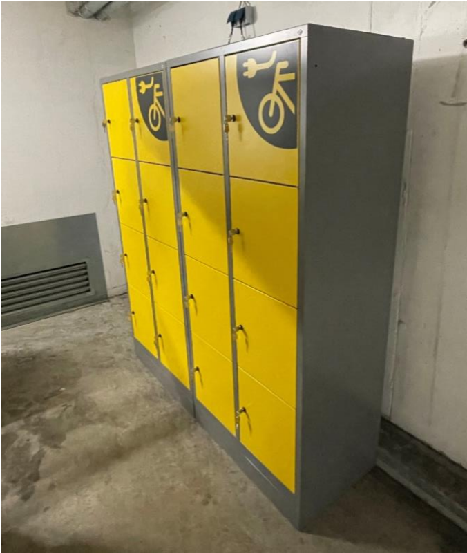
Abbildung 18 – Schließfachsystem für Akkus im hinteren Bereich der Tiefgarage
